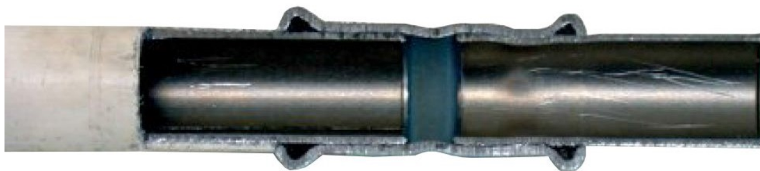
Lisovaný spoj – levá část před slisováním, pravá po slisování
