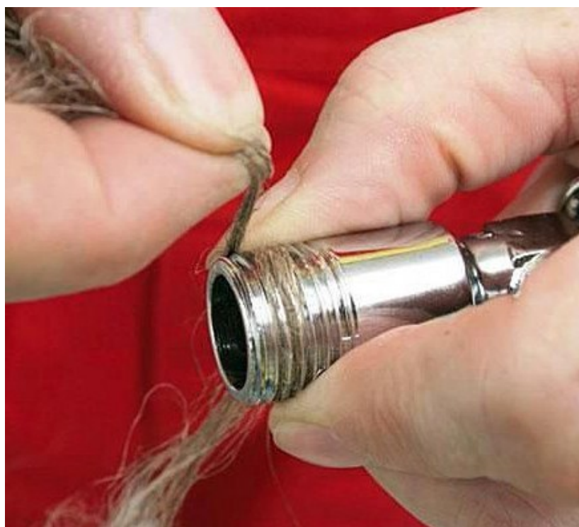
Těsnicí prostředky: Koudel, teflonová páska
