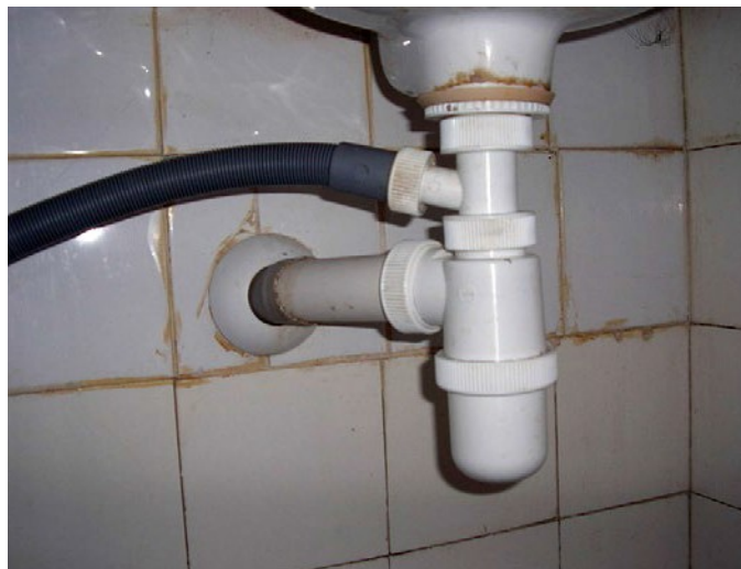
Zápachová uzávěrka pro montáž za zařizovací předmět
