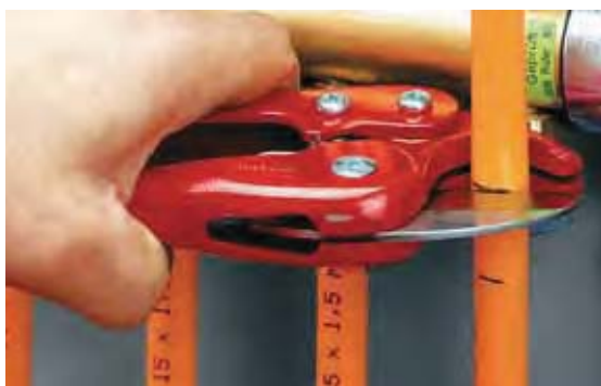
6b. Úprava délky trubky na horní značce
