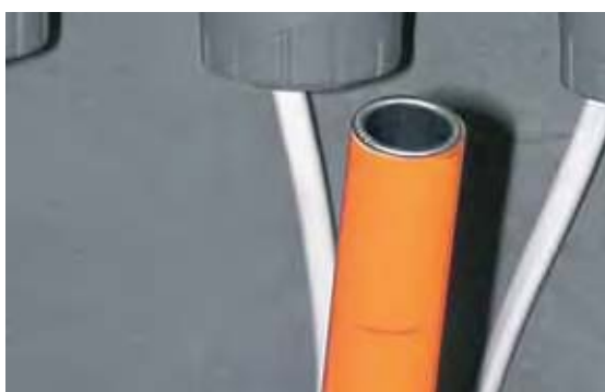
6d. Kontrola usazení opěrného pouzdra
