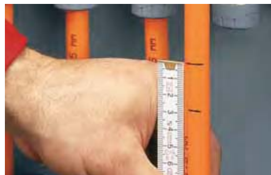
6a. Označení hloubky zasunutí 27 mm
