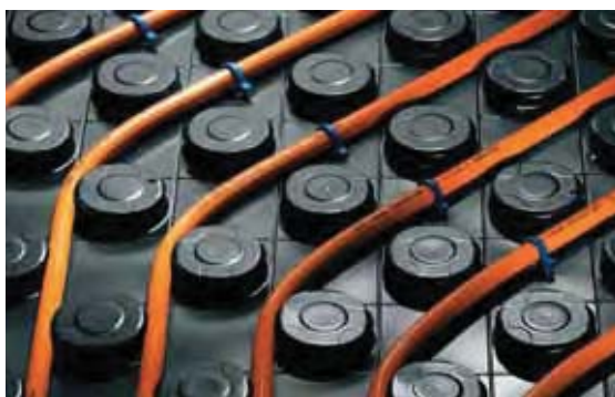
5b. Diagonální uložení s příchytami trubek
