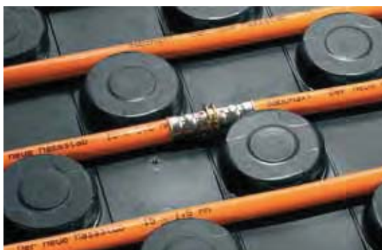
5c. Lisovaný spoj v konstrukci podlahy
