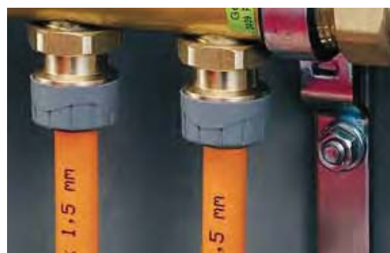
6e. Konec trubky do násuvné spojky
